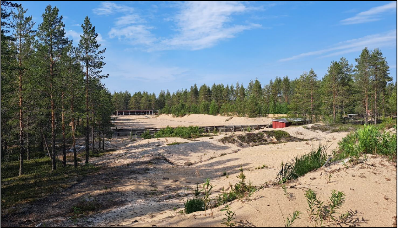
Kuva 12. Luodikkorata taustavallin päältä ampumapaikkojen suuntaan kuvattuna. Kuvassa keskellä on taululaitteet ja taustalla ampumakatos. 150 m taululaitteet ja taustavalli on suunniteltu suunnilleen kuvanotto paikalle. (Kuva: Esko Paananen/SAL)
