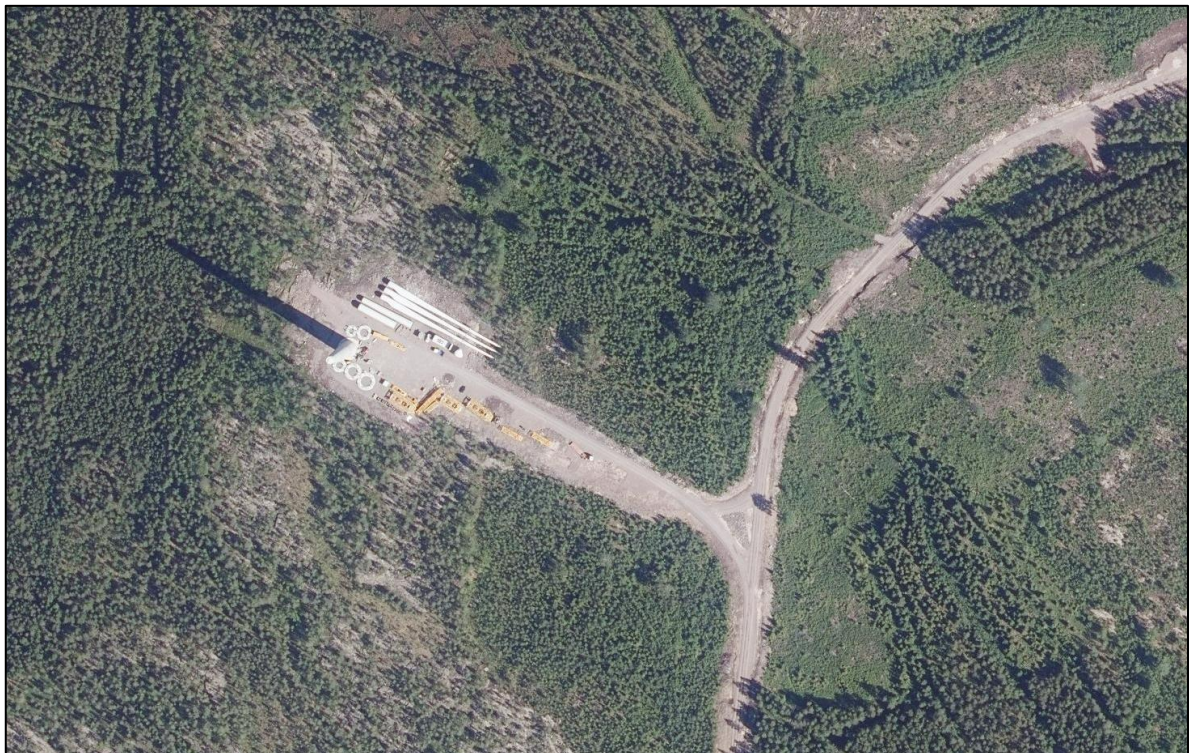
Kuva 4.2. Esimerkki valokuva rakennusvaiheessa olevan tuulivoimalan pystytys- ja työskentelyalueesta.
