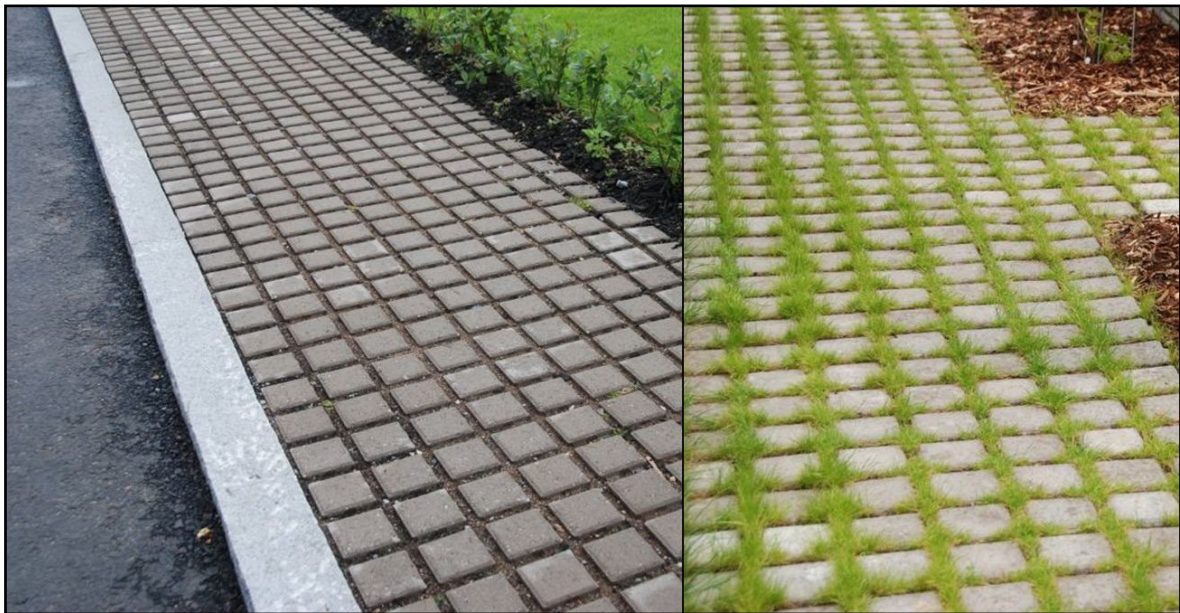
Kuva 11. Esimerkkejä läpäisevien päällysteiden käytöstä. 4
