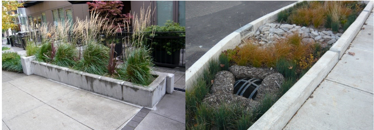
Kuva 9. Tyypikuva kattovesien viivytys-/imeytysjärjestelmästä. 4
