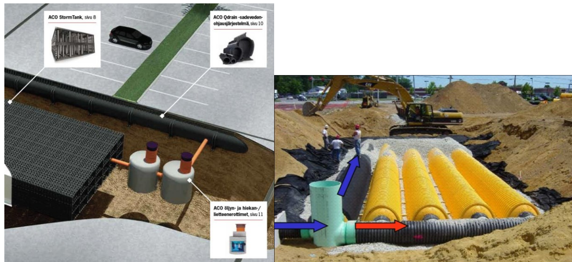
Kuva 13. Maanalainen viivytyjärjestelmä (vasemmalla hulevesikasettikenttä, 5 oikealla putki/kammarikenttä 6 ).
