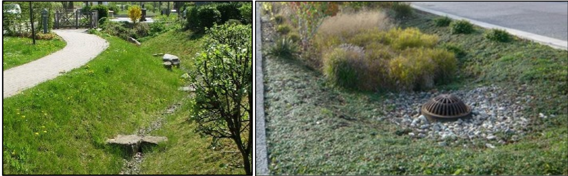
Kuva 14. Vasen kuva: Esimerkki hulevesien pintajohtamista kadun reunaosassa, johon on istutettu kasvillisuutta ja rakennettu pohjapatoja. 4 Oikea kuva: Esimerkki katualueen viherpainanteesta, jossa on ylivuotojärjestelmä hulevesiviemäriverkkoon (Seattle, USA). 4
