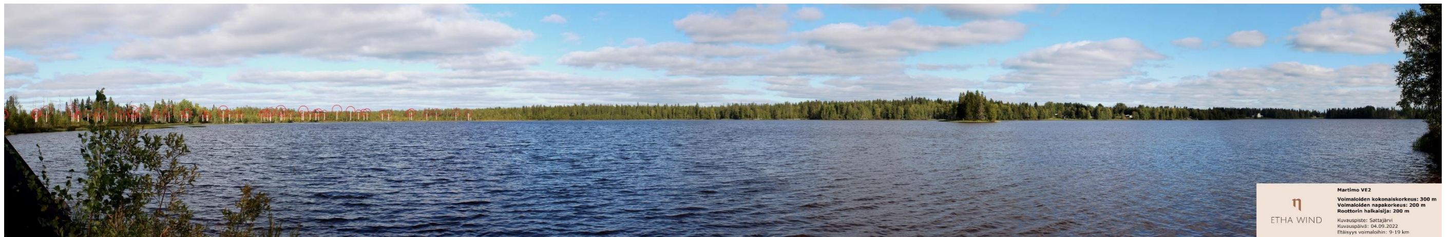
Kuva 5.5. Vaihtoehdon VE2 havainnekuva Sattajärven länsirannalta. Kuvassa on korostettu voimaloiden tornit valkoisilla viivoilla ja lapojen pyörimisaluet punaisilla ympyröillä.
