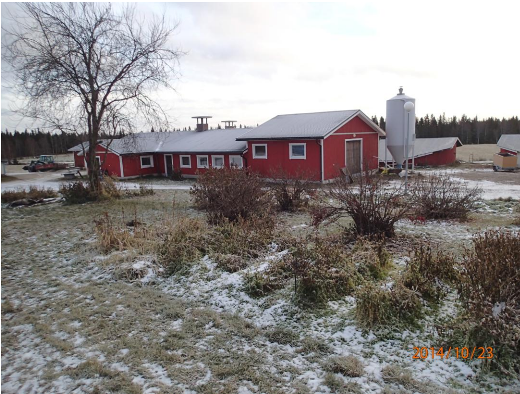
Kuva 10 Eläinsuojarakennus 1 ja rehuvarasto, taustalla lietalantasäiliöt
