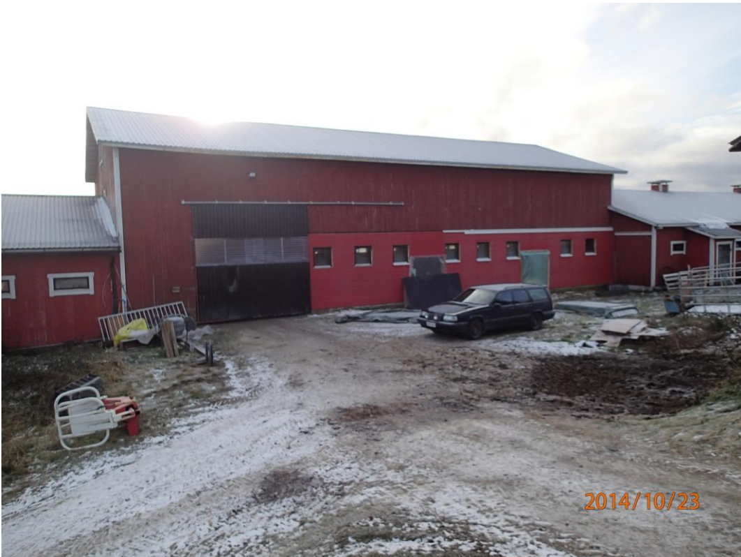
Kuva 4 Kuivurilato, suunniteltu eläinsuojan laajennuspaikka. Lampola oikealla.
