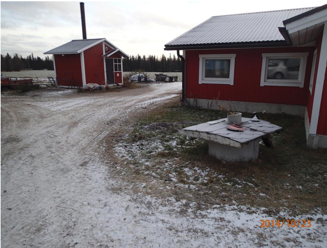
Kuva 11 Eläinsuojarakennus 1, kaivo ja lämpökeskus
