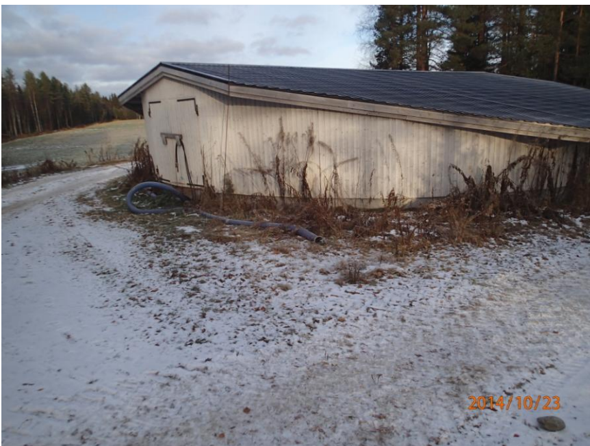
Kuva 6 Tilakeskuksen länsipuolella sijaitseva lietelantasäiliö
