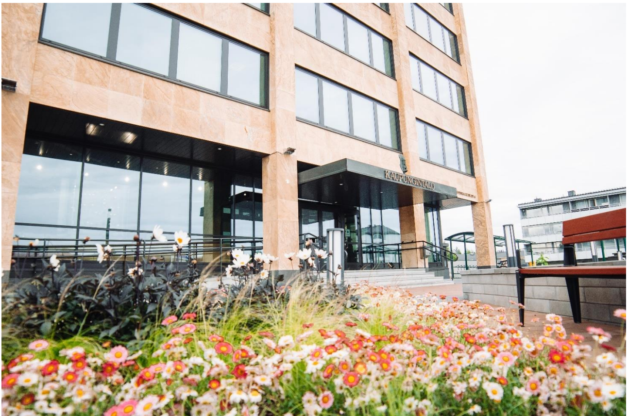
Kuva: Tornion kaupunki
